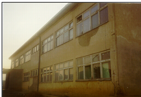
La scuola di Stublla prima dell'intervento ipsia
