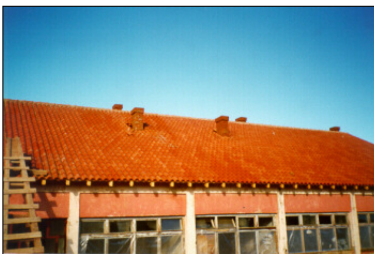
Il tetto ricostruito della scuola di Debolde
