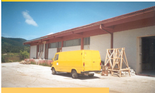
RIBNIK - Ristrutturazione del capannone
