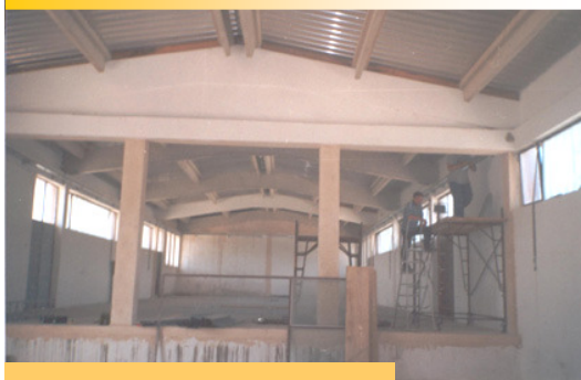
RIBNIK - Ristrutturazione degli interni
